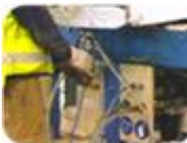
Figura 13 - Remoção do óleo do compressor e do gás refrigerante
