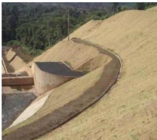
Figura 7 – Biomanta de fibra de coco aplicada em talude
